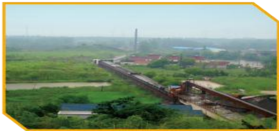
新开元采用全封闭式皮带长廊运输，提高石料输送能力并减少运输过程中粉尘和噪音污染
