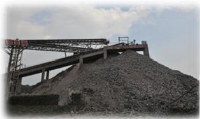
❖ 中间料场封闭前
