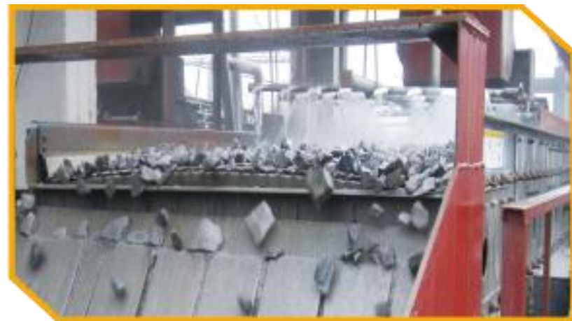
湖州新开元生产区彩钢墙内喷淋降尘，防止矿尘对当地环境的污染
