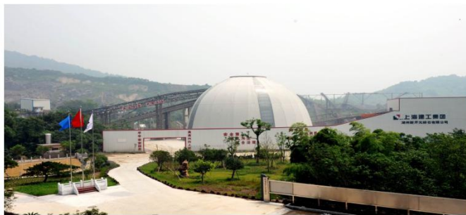
❖ 中间料场封闭后
