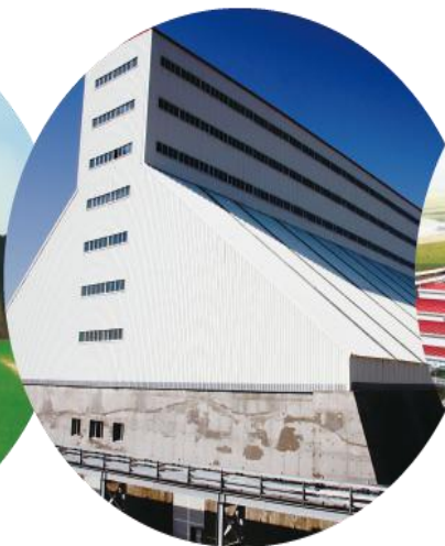
为避免露天采矿对草原的影响，乌山铜钼矿建成了我国第一个最大的封闭式原矿储堆，储矿能力达12万吨，从根本上解决了原矿扬尘、污染问题
