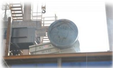
❖ 头破车间封闭前
