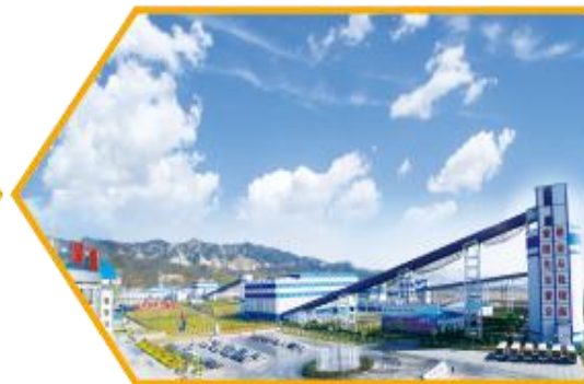
塔山运煤栈桥
