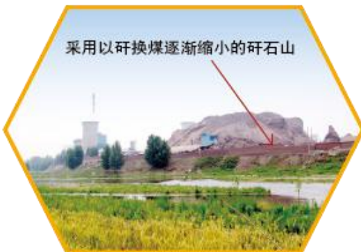
孙村煤矿通过采用“以矸换煤”技术,减少煤矸石堆放占用耕地200多亩,同时盘活煤炭资源2.5亿吨,煤炭回采率达到95%
