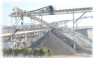
❖ 石粉料场封闭前
