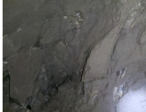
照片 3-2 坑道中顶板岩石松动的痕迹
